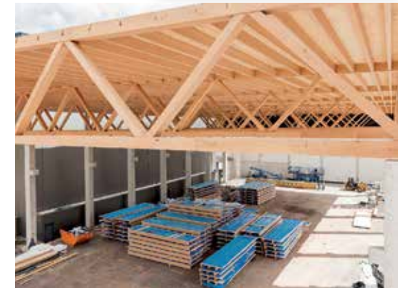
Lagerhallenüberdachung aus Buchen-Furnierschichtholz der Firma Pollmeier. Foto: Alex Schmitt
